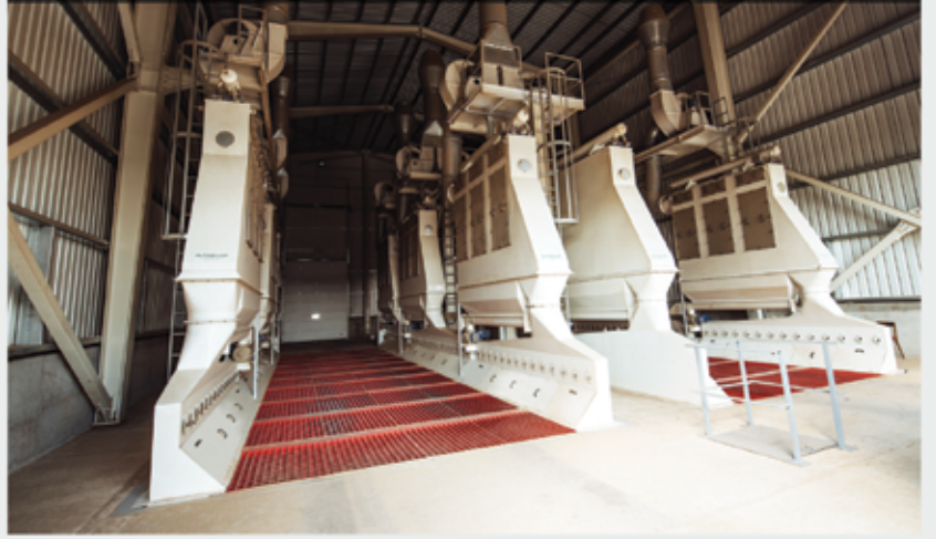
Tozsuzlaştırılmış Mal Alım Çukuru
